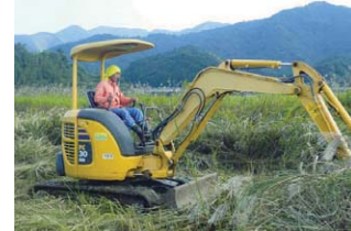
えさ場周辺部の除草活動。雑草が3m近く伸びていたため、重機を用いて実施
